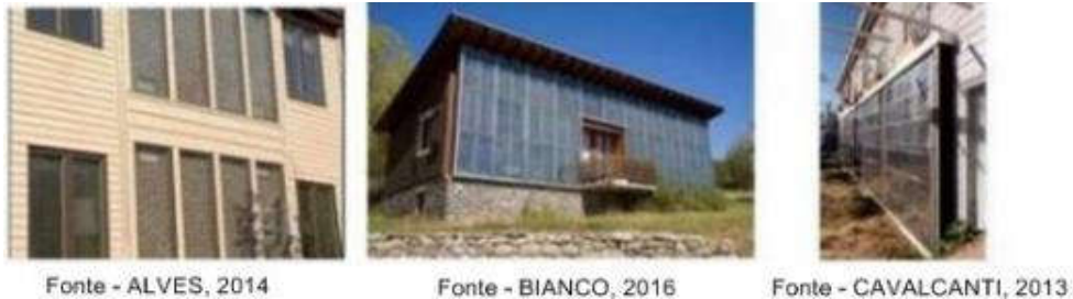
Figura 6- Parede acumuladora totalmente exposta
