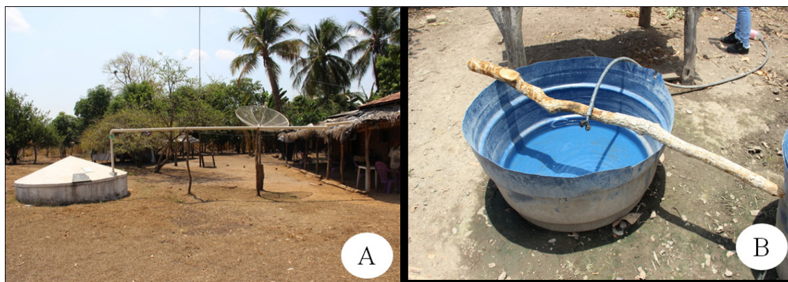
Figura 4- A. Cisterna instalada em um dos lotes do assentamento. B. Vasilhame que armazena água salobra utilizada para o canteiro e animais
